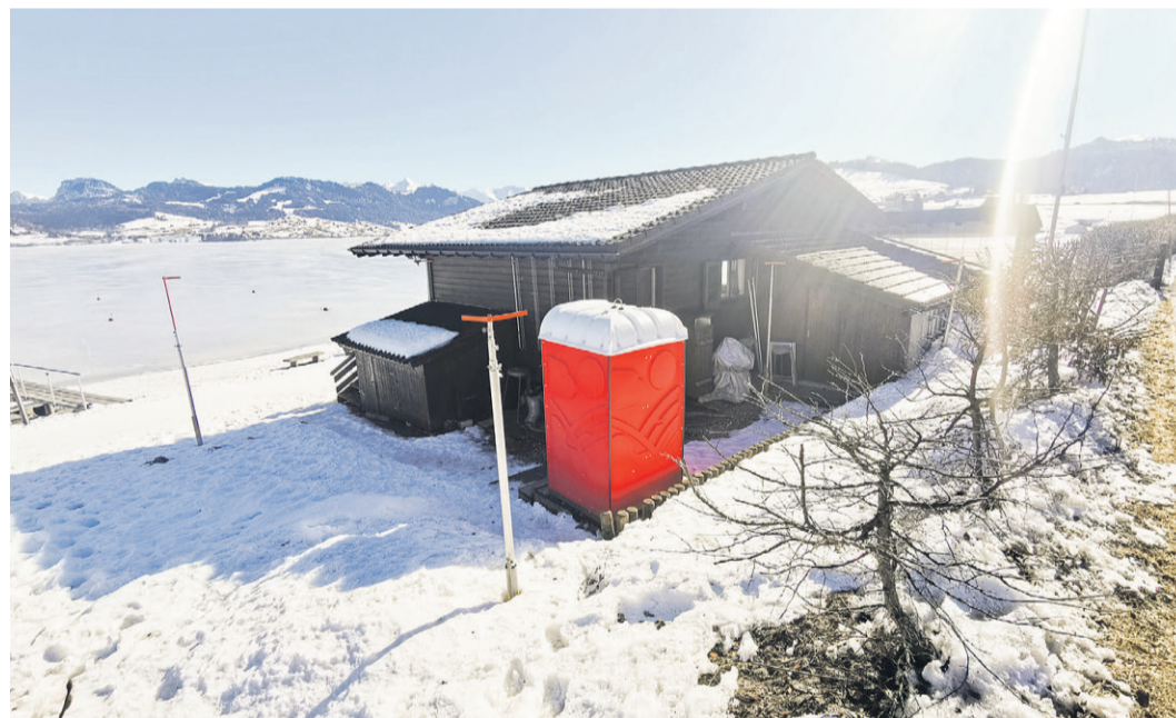
Der Anbau der Toiletten und Duschen erfolgt parallel zur Staumauerstrasse.
